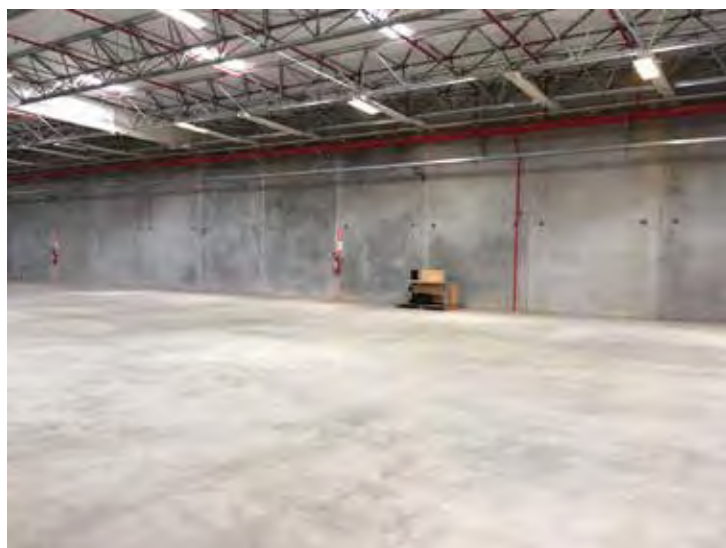
Vista interna do galpão
