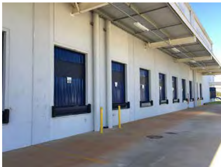
Área de marquise e docas
