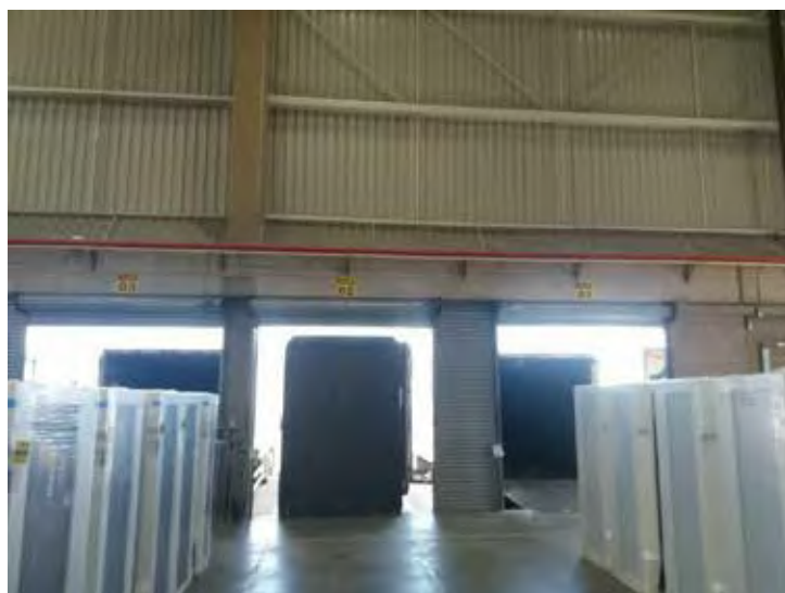
Área de marquise e galpão
