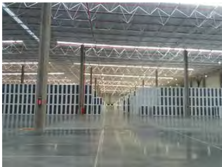
Vista interna do galpão
