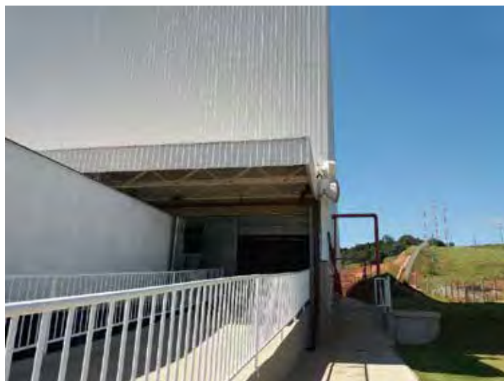
Área de marquise e galpão
